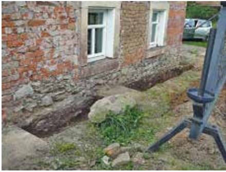
Freigelegte Grundmauer aus Natursteinen, Lehmziegeln und modernen Ziegeln.
