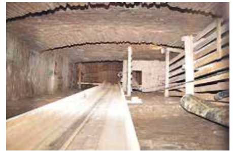
Temporärer Schachtausbau während der Verwahrung.
