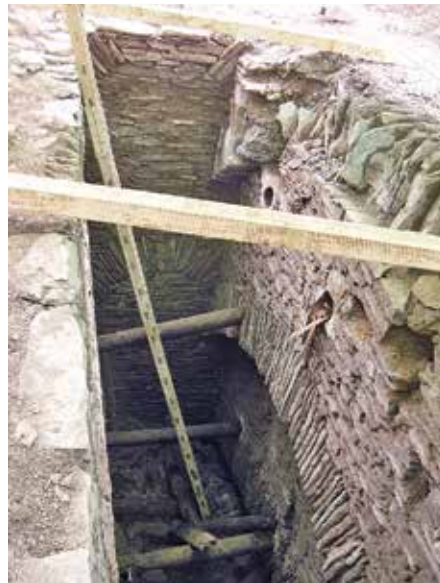
Schachtkopf nach der Freilegung.
