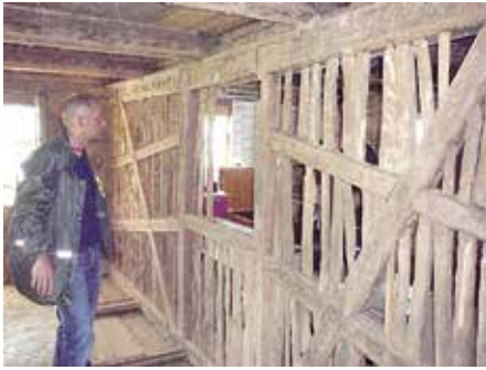
Freigelegte Fachwerkwand im Obergeschoss.
