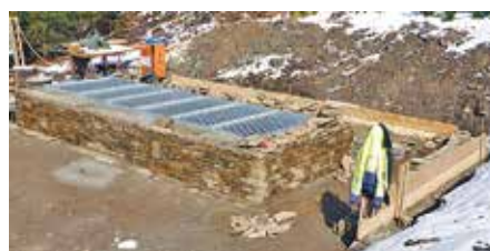
Einbau der Gitterrostabdeckung.
