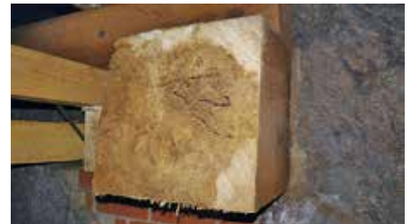
Querschnitt des Balkens nach 20 Jahren vor Ort. Fotos: Gerold Riedl
