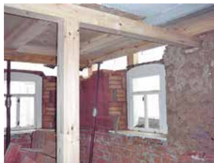
Erneuerung der Deckentragbalken im Erdgeschoss.
