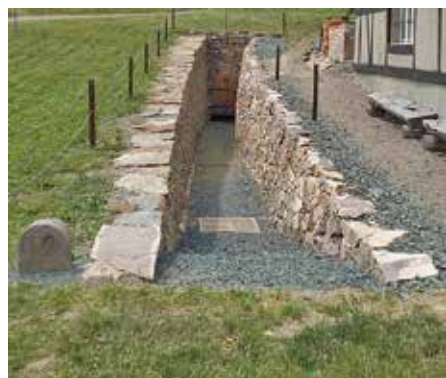
Das fertige Mundloch.
