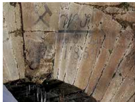
Detailfoto zeigt die Inschriften am Mundloch von 1846 deutlich erkennbar rechts die Hochwassermarke vom 9. Juli 1854.
