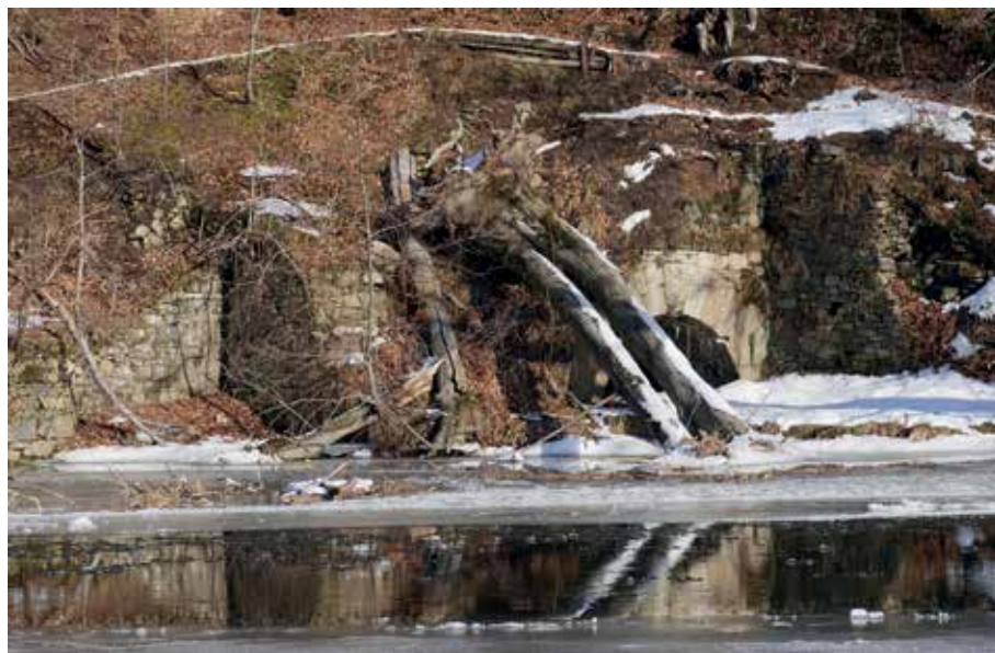
Blick vom gegenüberliegenden Zschopauufer auf das Mundloch der älteren Aufschlagrösche von 1843 (rechts) und der verwahrten Aufschlagrösche von 1864 (Mauerung links im Bild). Fotos: Gerold Riedl
