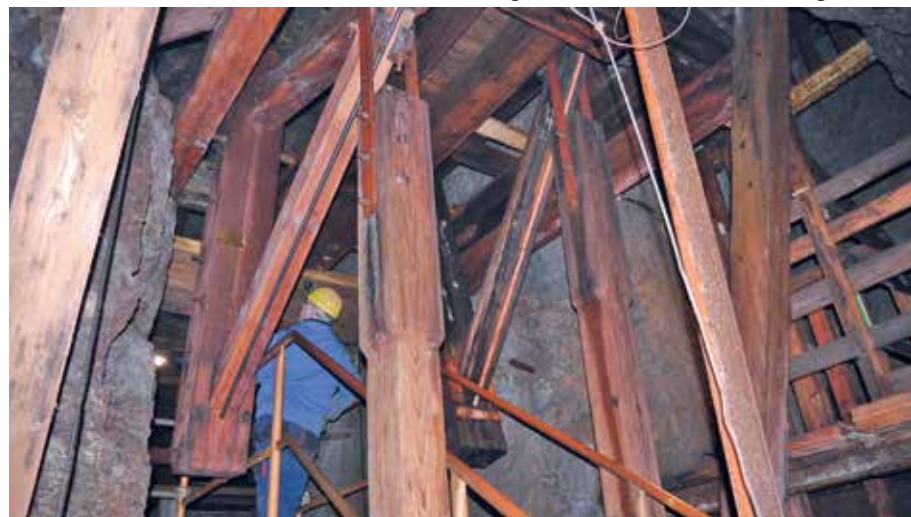
Die Kunstwinkel mit Gestänge kurz vor der Wiederinbetriebnahme.
