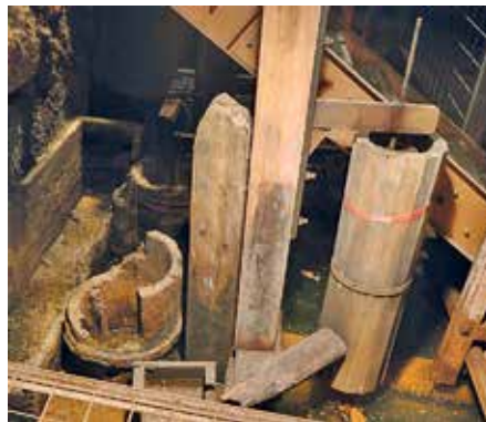
Fertig verbautes Balken- und Pfostenpaket unter Tage.
