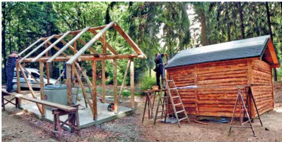
Stellen des Grundgerüsts der Kaue auf dem Schachtkopf des Wetterschachtes und die fertige Kaue mit Dacheindeckung des Holzgebäudes. Fotos: Wolfgang Prehl (Fotomontage Haeßler)
