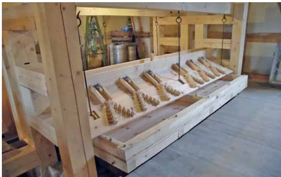
Fertiggestellter Querstoßherd im Wäscheraum der Fundgrube.
