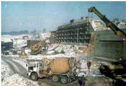
Baustelle „Neue Bleihütte“
