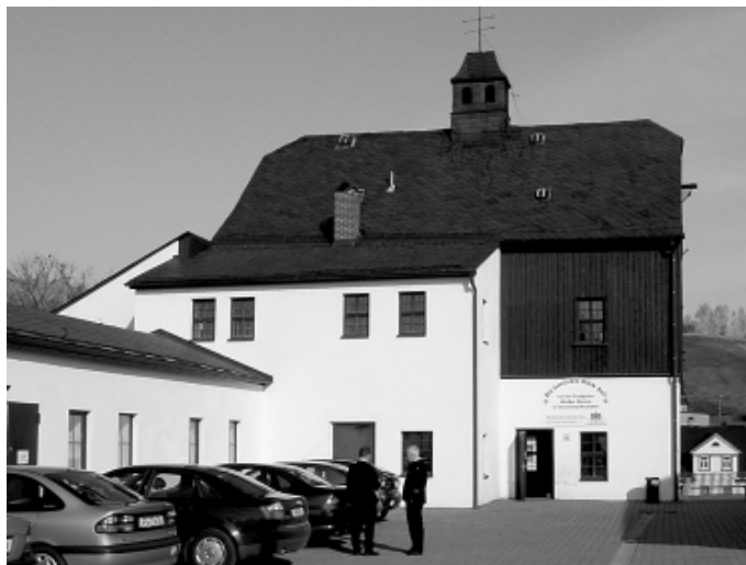
Huthaus der Fundgrube „Weisser Hirsch“ auf dem Gelände der Bergsicherung Schneeberg. Foto Gerd Melzer
