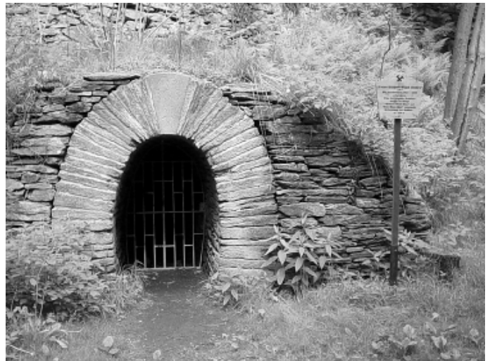
Mundloch des „Tief Blühend Glück Stolln“ in Pobershau, Hinterer Grund
