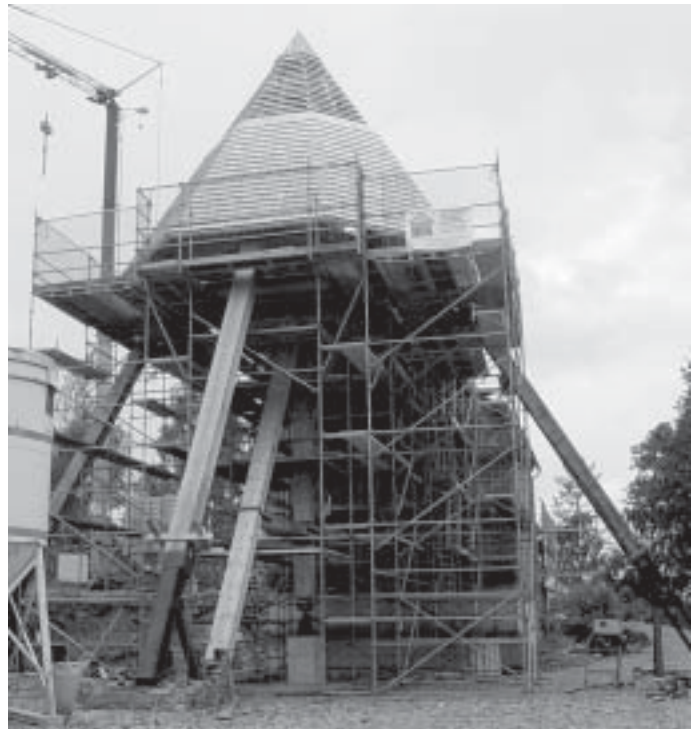
Der neue Pferdegöpel auf dem Rudolphschacht im Rohbau Fotos: Jochen Rosenberger
