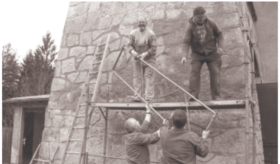
Gesamt der Sockel ist komplett neu verfügt. Bergbrüder bauen das Gerüst ab. Foto: Anja Rothemann
