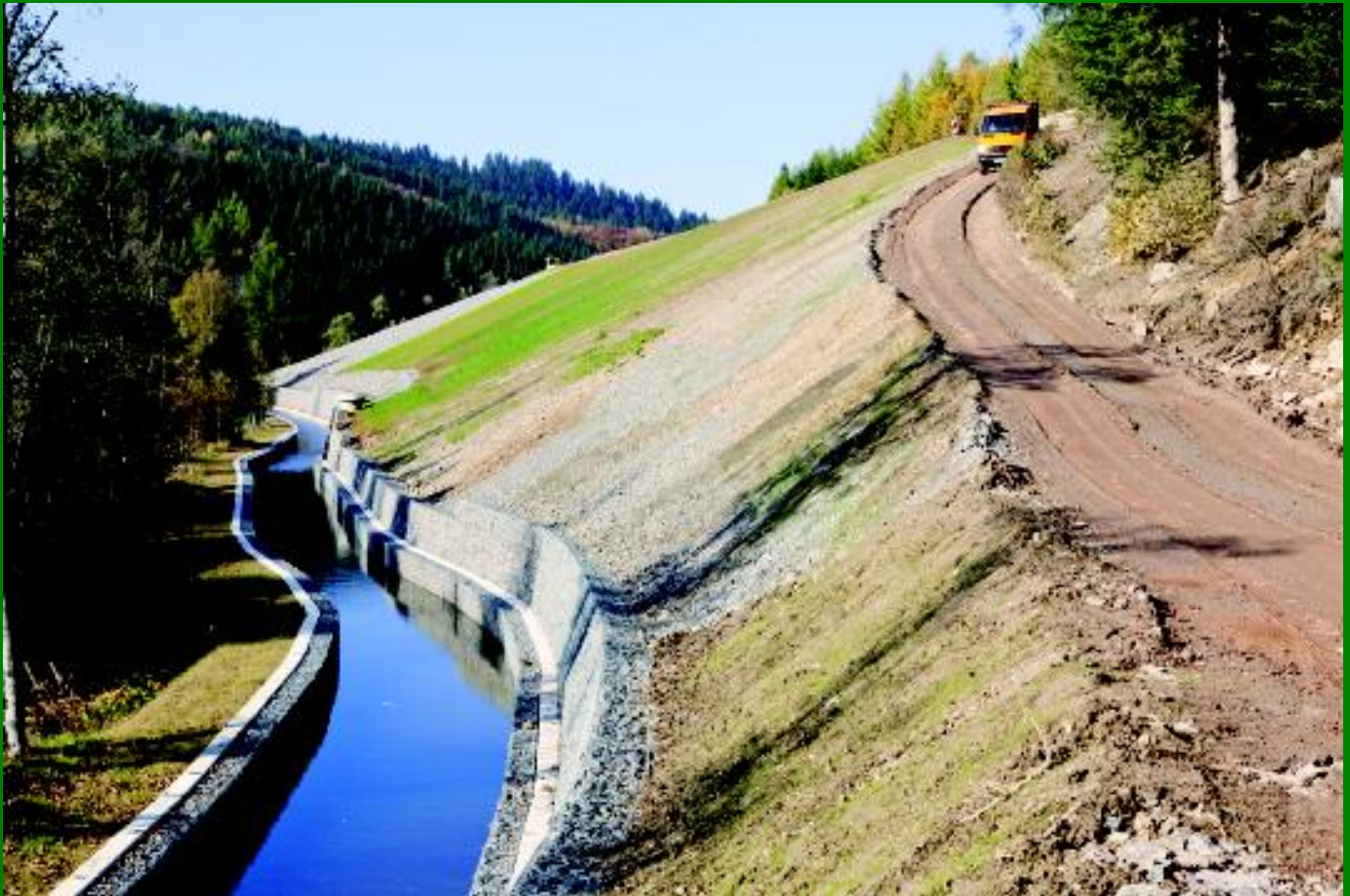
Sanierung der Halde Haberlandmühle durch Bergsicherung Schneeberg unweit von Johanngeorgenstadt. Fotos: Thomas Ackermann, Wismut GmbH
