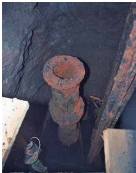
1994 Das Wasserabsenken legt eine beeindruckende Technik frei.
