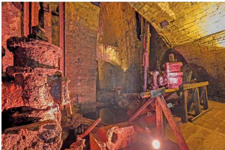
Brendelsche Wassersäulenmaschine im Josephschacht Gersdorf. Foto: Verein SGE
