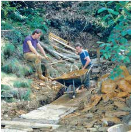
Erste Schachtarbeiten am Stollenmundloch.
