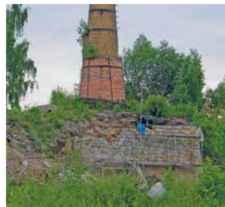
Die Anlage vor der Sanierung vor der Sanierung. Fotos: Verein
