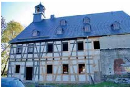
Zustand des Pochwerkes am 21. August 2008, jetzt schon mit neuem Dach und neu aufgesetztem Glockenturm
