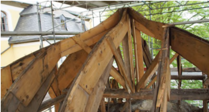
Der freigelegte Dachstuhl der Bergmeisterkapelle (Foto: Stephan Schmidt-Brücken)
