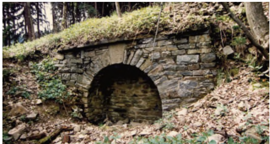
Das 1991 mit einer 6 Meter Betonblombe verwehrte Mundloch des „Engländerstollns“ vor der Aufwältigung im Jahr 2003 (Fotos: Archiv der Kirchberger Natur- und Heimatfreunde)
