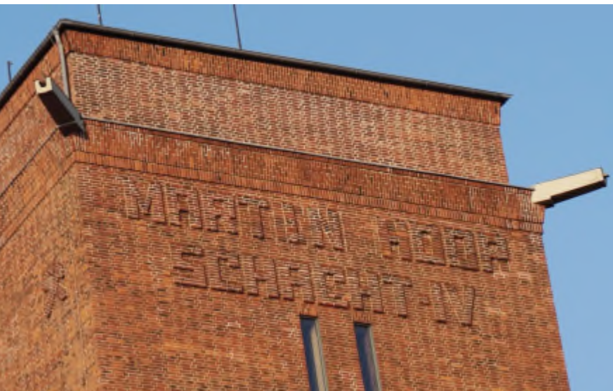
Detailsicht des aktuellen Schriftbandes mit erkennbaren Spuren der alten Inschrift
