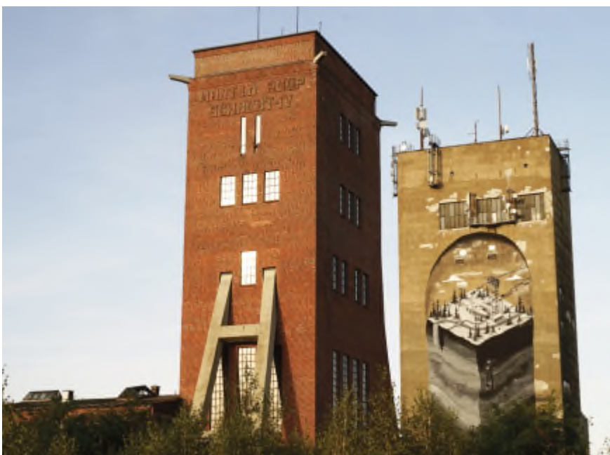
Die Fördertürme von Martin-Hoop IV und IVa im aktuellen Zustand (Bildquelle: Helmar Sittner)
