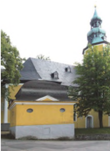
Ansicht der Bergmeisterkapelle von der Pfarrstraße (Foto: Stephan Schmidt-Brücken)
