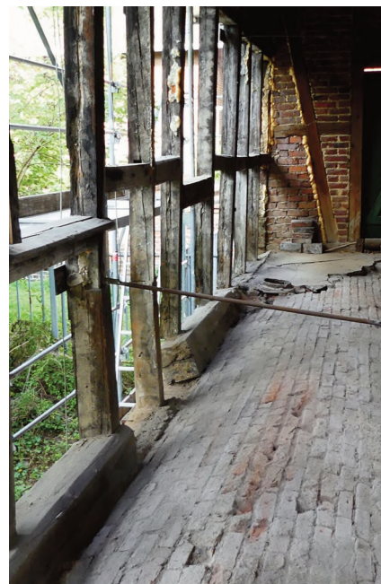
Die freigelegte nördliche Giebelwand mit stark geschädigtem Fachwerk und der einsturzgefährdeten Gewölbemauerung
