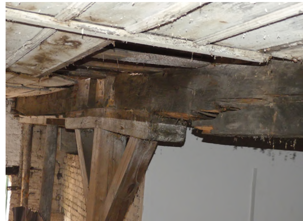
Der Hauptträger der Holzdecke im südlichen Gebäudeteil war mehrfach gebrochen und musste neu eingebaut werden
