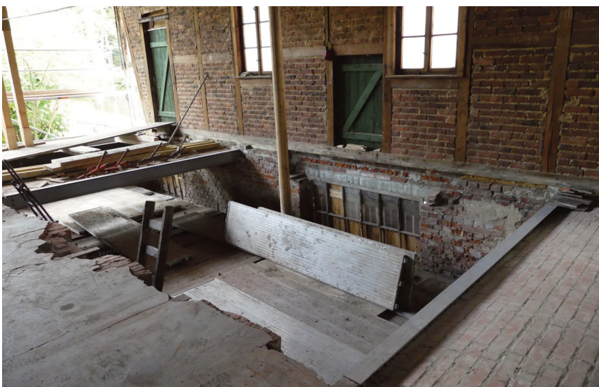
Im östlichen Teil des Nordflügels musste die komplette Gewölbedecke neu aufgebaut werden
