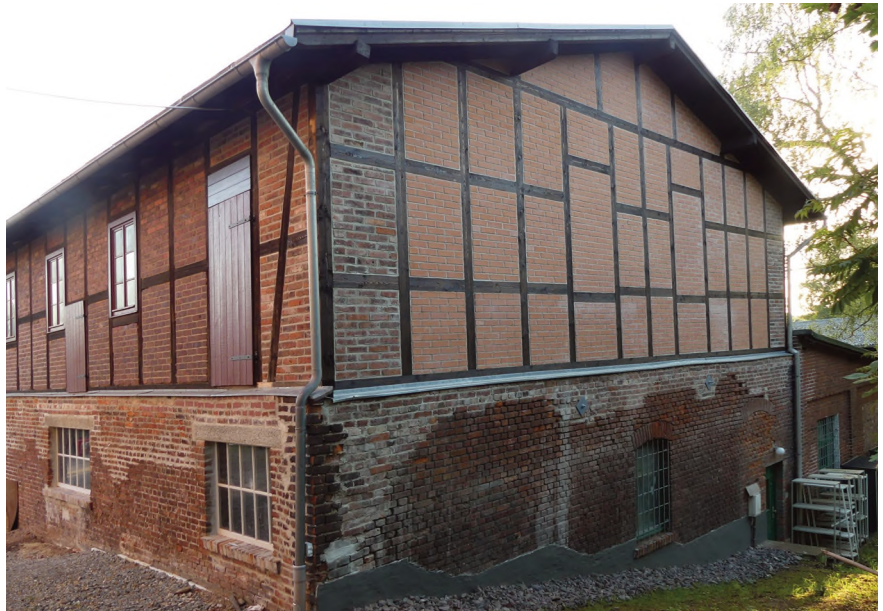
Die neu aufgebaute nördliche Giebelwand mit sichtbarer Mauerwerksabdichtung im Bodenbereich.
