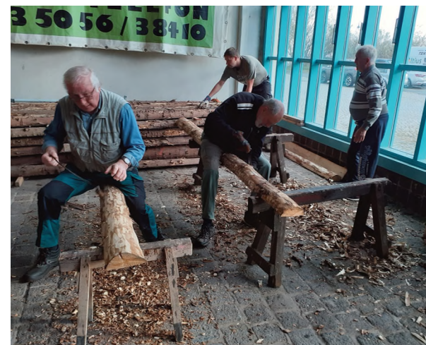
Zurichtung der Ausbauhölzer für den Türstockausbau für den Standort des Traditionsförderhundes (Foto: Eckhard Ehrht)
