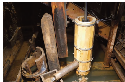
Im Clementine Kunst- und Treibeschacht konnte neben den historischen Pumpsätzen der überarbeitete neue Pumpsatz montiert werden
