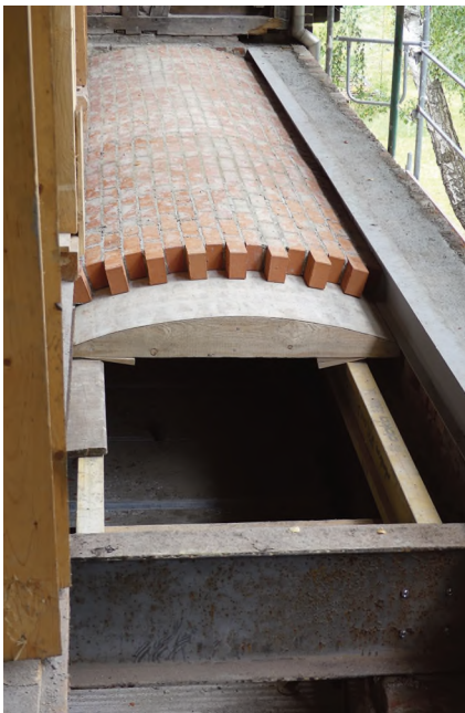
Nach Mauersanierung und Setzen des Ringankers konnte die Gewölbemauerung neu aufgebaut werden
