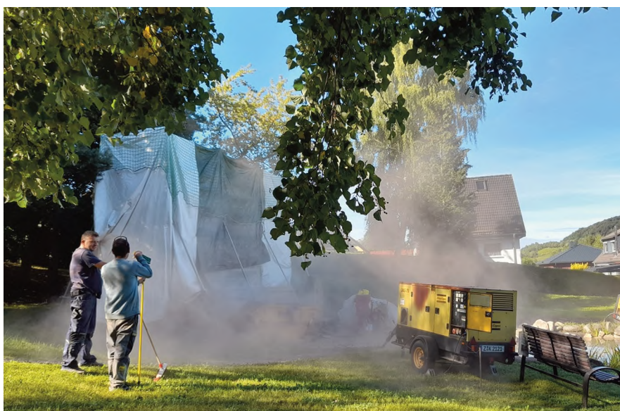
Das Sandstrahlen ist in vollem Gange – es staubte ordentlich
