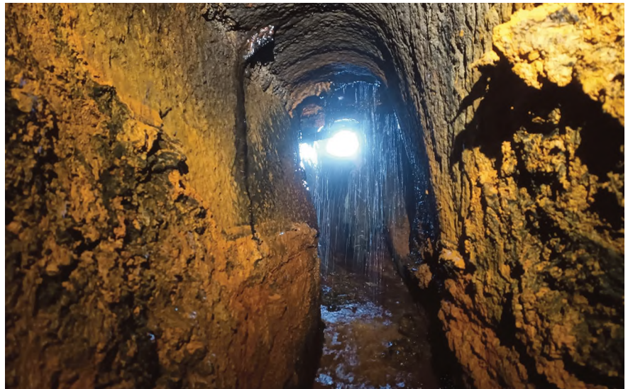
Wassereinbruch im Vetter-Michel-Schacht.
